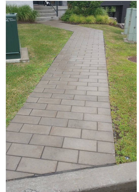
Allées simples en pavés de béton préfabriqués
