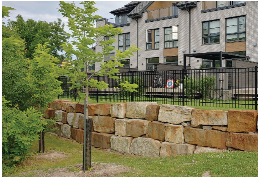
Mur de soutènement en pierres et clôture séparant les résidences voisines du parc
