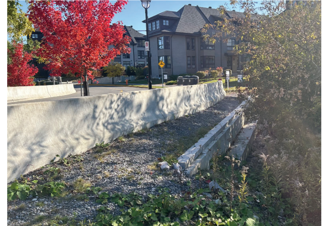
Extrémité du terrain avec ponceau pour le ruisseau
