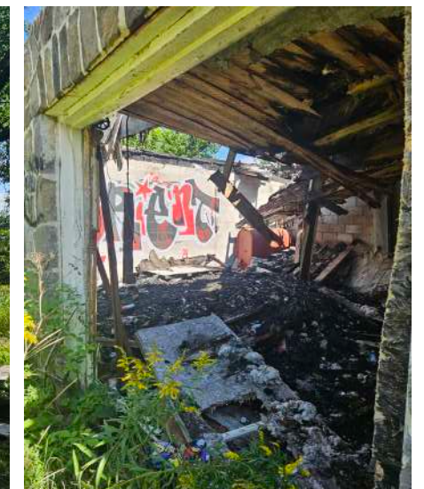
8_Vue intérieure du garage.
