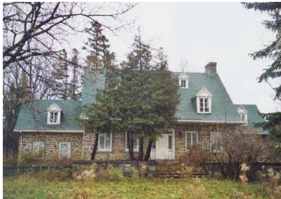
1_État de la maison en 2006. (Source: Guillaume St-Jean, Flickr)
