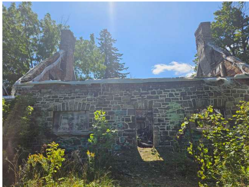
1_Mur du corps central, façade nord.
