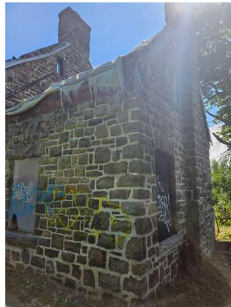
2_Mur de l'aile ouest, façade nord.
