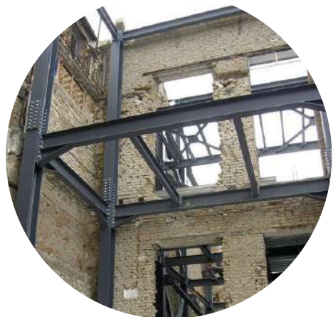
STRUCTURE DE STABILISATION EN ACIER GALVANISÉ
