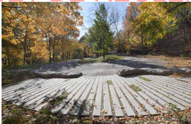
Figure 16 — Aménagement de sentiers comprenant des matériaux perméables
