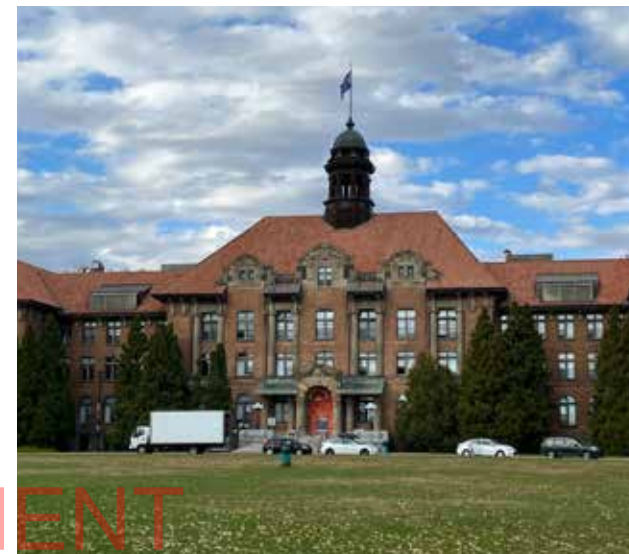
Figure 27 — Bâtiments compris sur le campus Macdonald
