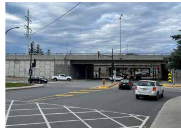
Figure 23 — Viaduc de l'autoroute 20 passant au-dessus du boulevard des Anciens-Combattants
