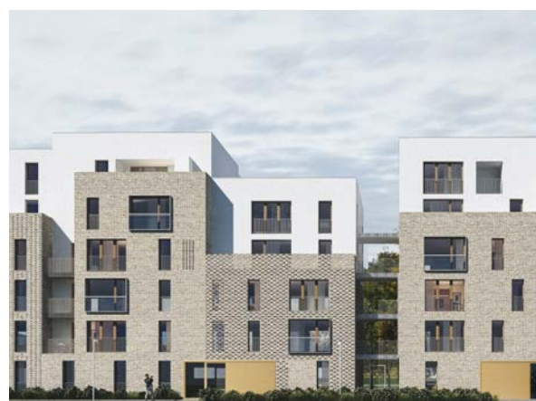
» 98 Logements collectifs, Aubervilliers, France. @ RMDM
