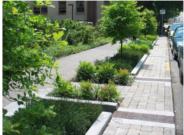
⤴ Portland's south waterfront © nevue ngan associates Mesures de rétention des eaux pluviales à l'aide de noues végétalisées
