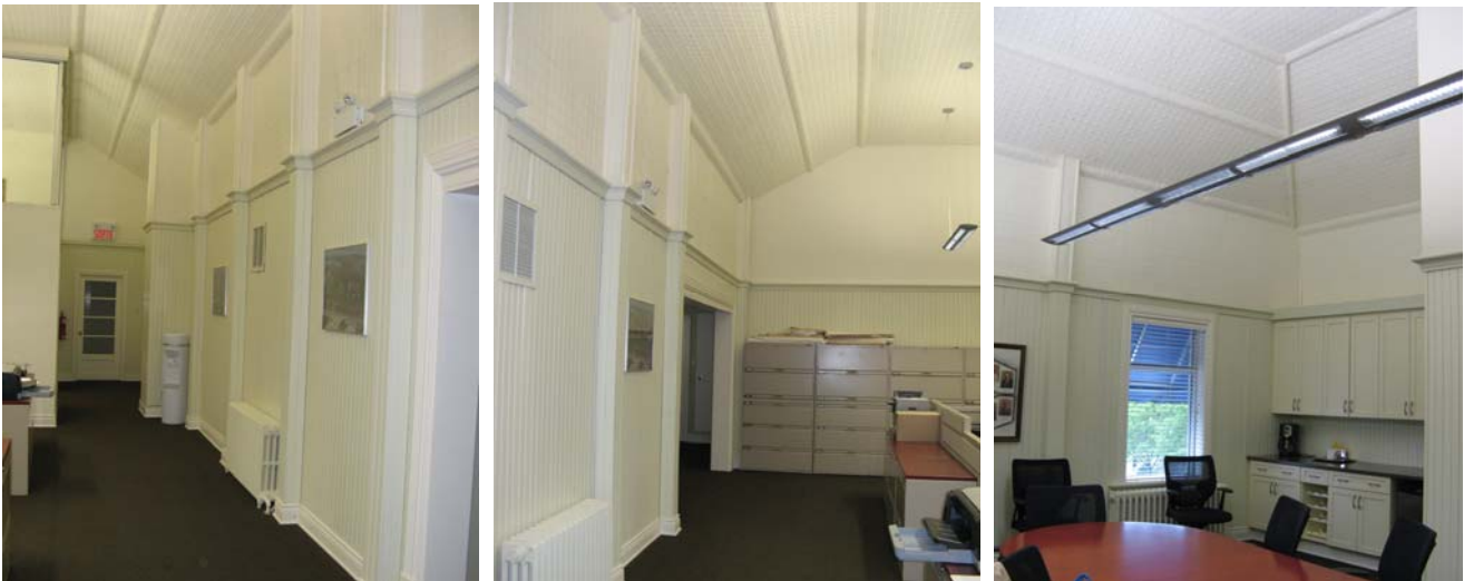
41, 42 & 43. Vues générales à l'étage, 2009 (Lafontaine & Soucy)
