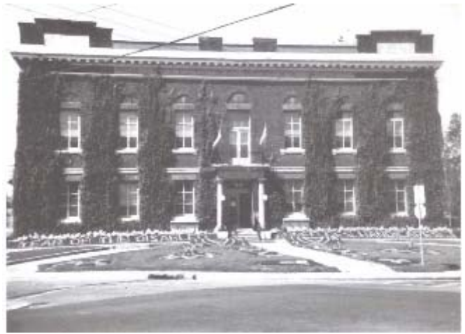
50. Façade hôtel de ville de Montréal-Ouest, 1981 (CUM)
