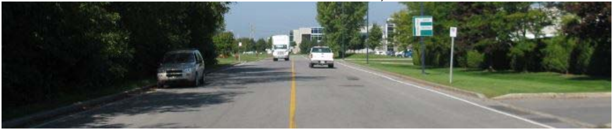
Photo 2.2.6 - Chemin Sainte-Marie à l'intersection du boulevard Morgan, vue en direction ouest
