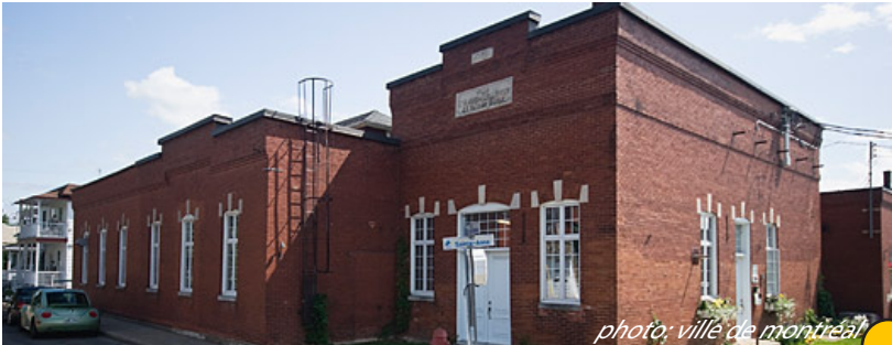
usine de filtration
